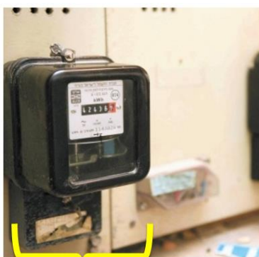
מד חשמל פשוט, ממוקם באזור צדדי או מחוץ לדירה. בבדיקה לעיתים רחוקות ולא מיידי.
